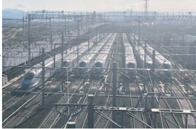
北陸新幹線の車両基地
