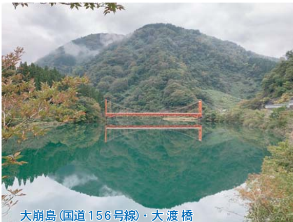
大崩島(国道156号線)・大渡橋
